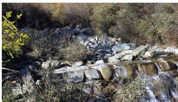
Figura 6.3: opere di sistemazione del rio Bedù di Pelugo nel tratto sommitale del conoide
