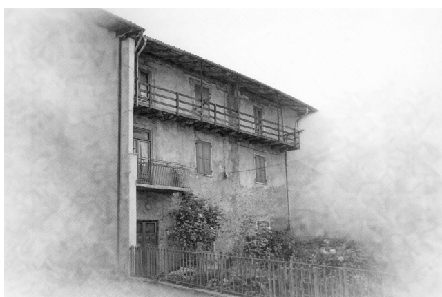
Balconi tipici del centro storico con parapetto ad aste orizzontali
