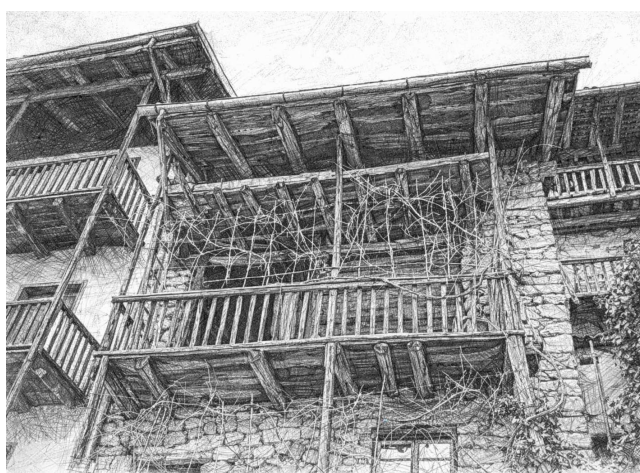
Ballatoi in legno sottogronda
